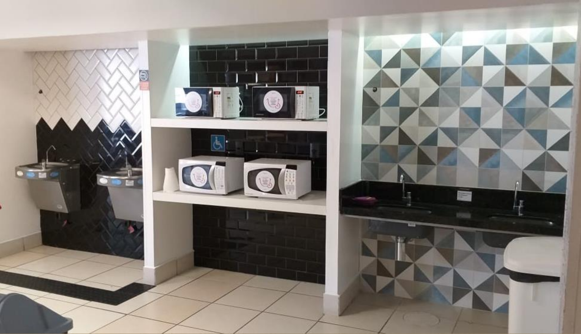
Obra: Atento – Site Madureira Retrofit de Áreas Internas Local: Rio de Janeiro - RJ Ano de Finalização: 2019
