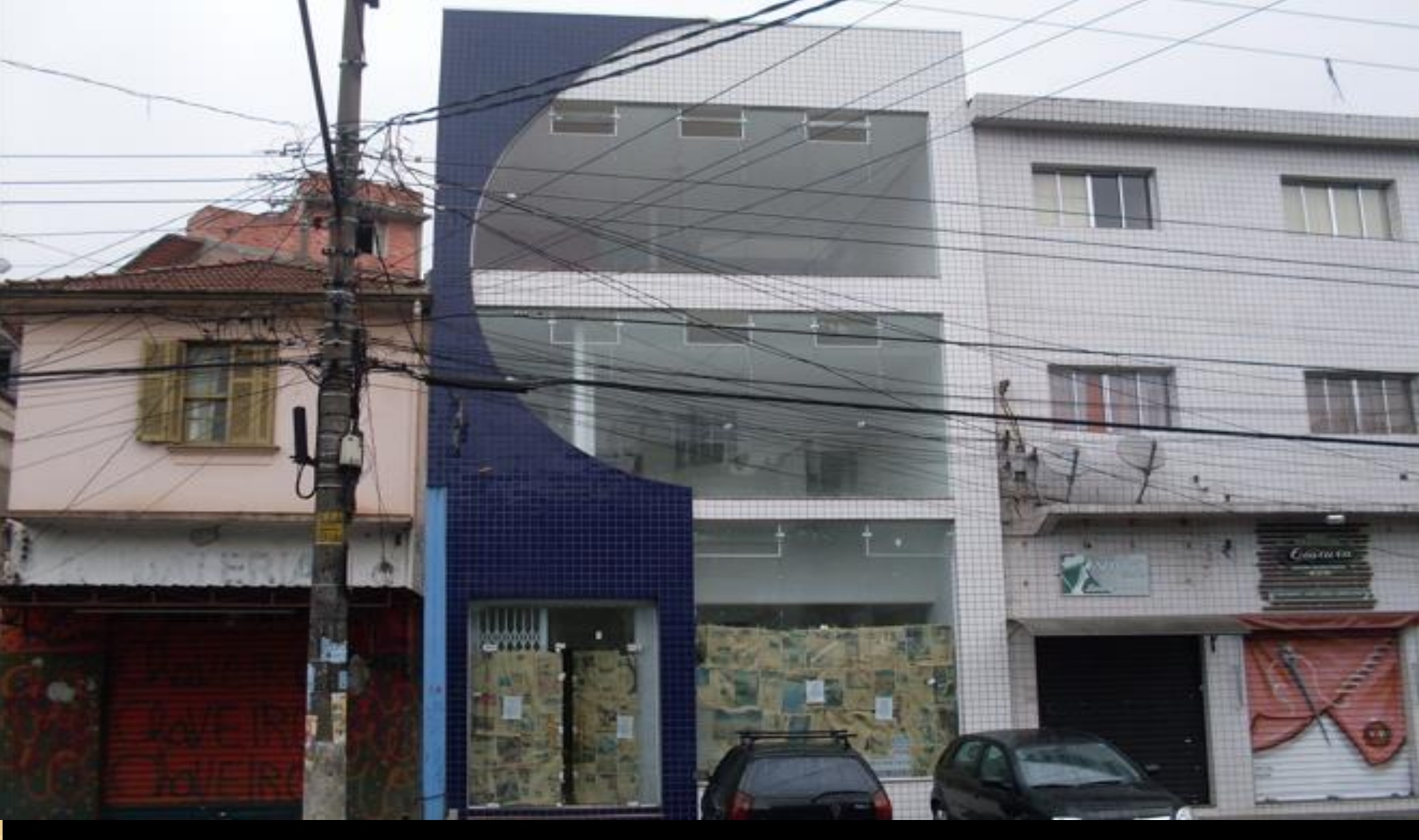
Obra: Rose Marrys Instituto de Beleza Edifício Comercial em Concreto Armado Local: São Paulo – SP Ano de Finalização: 2007
