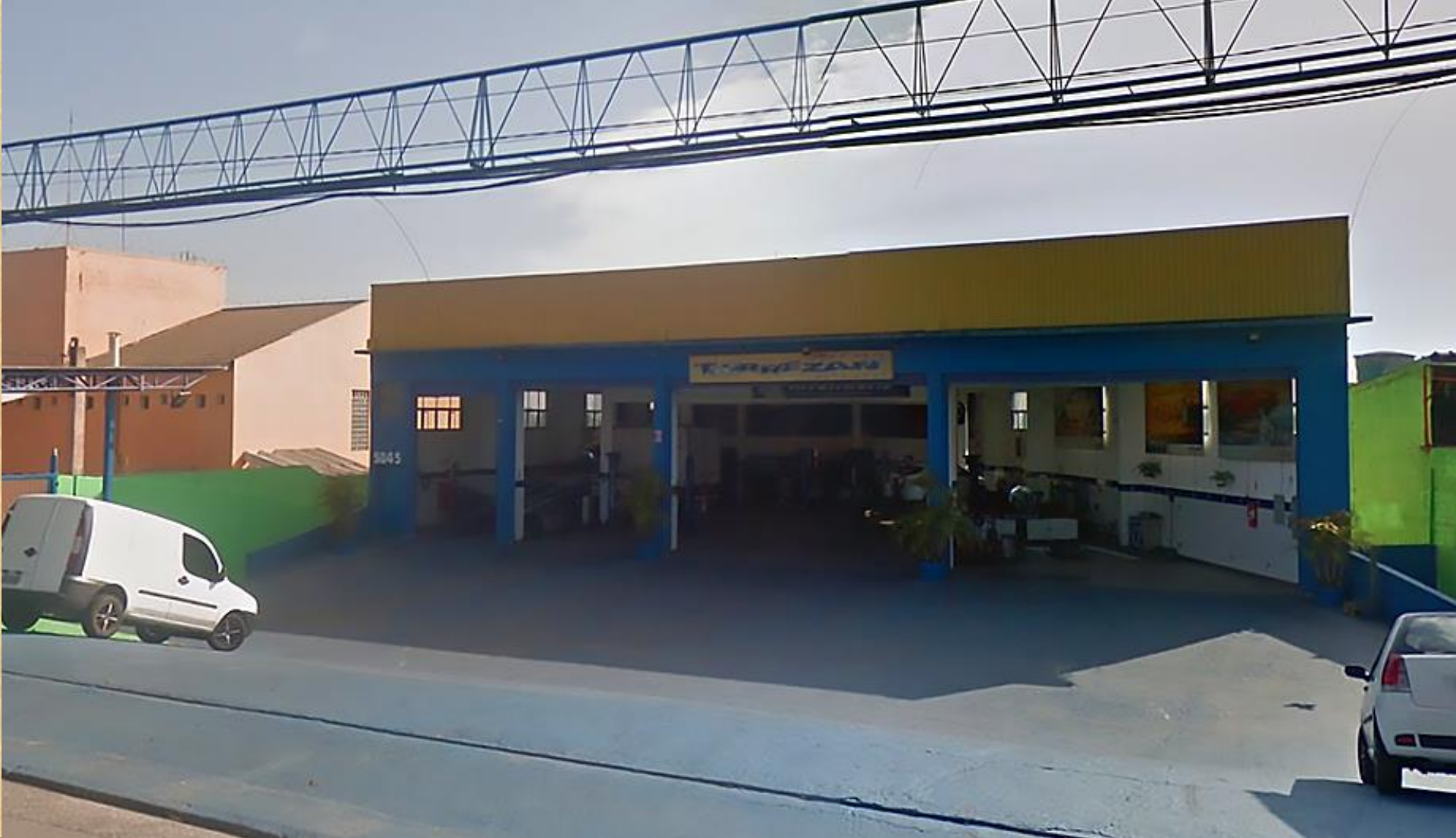
Obra: Torrezan Pneus Edifício Comercial em Concreto Armado Local: São Paulo – SP Ano de Finalização: 2007
