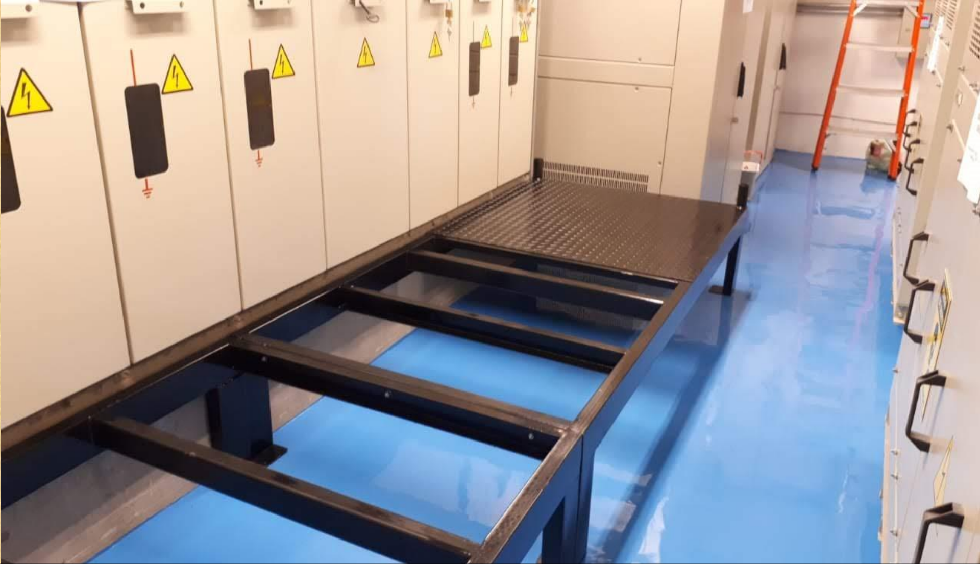
Obra: Hospital Albert Einstein – Unidade Perdizes Realização de Piso Epóxi Monolítico e Plataforma Metálica em Cabine Primária Local: São Paulo – SP Ano de Finalização: 2019
