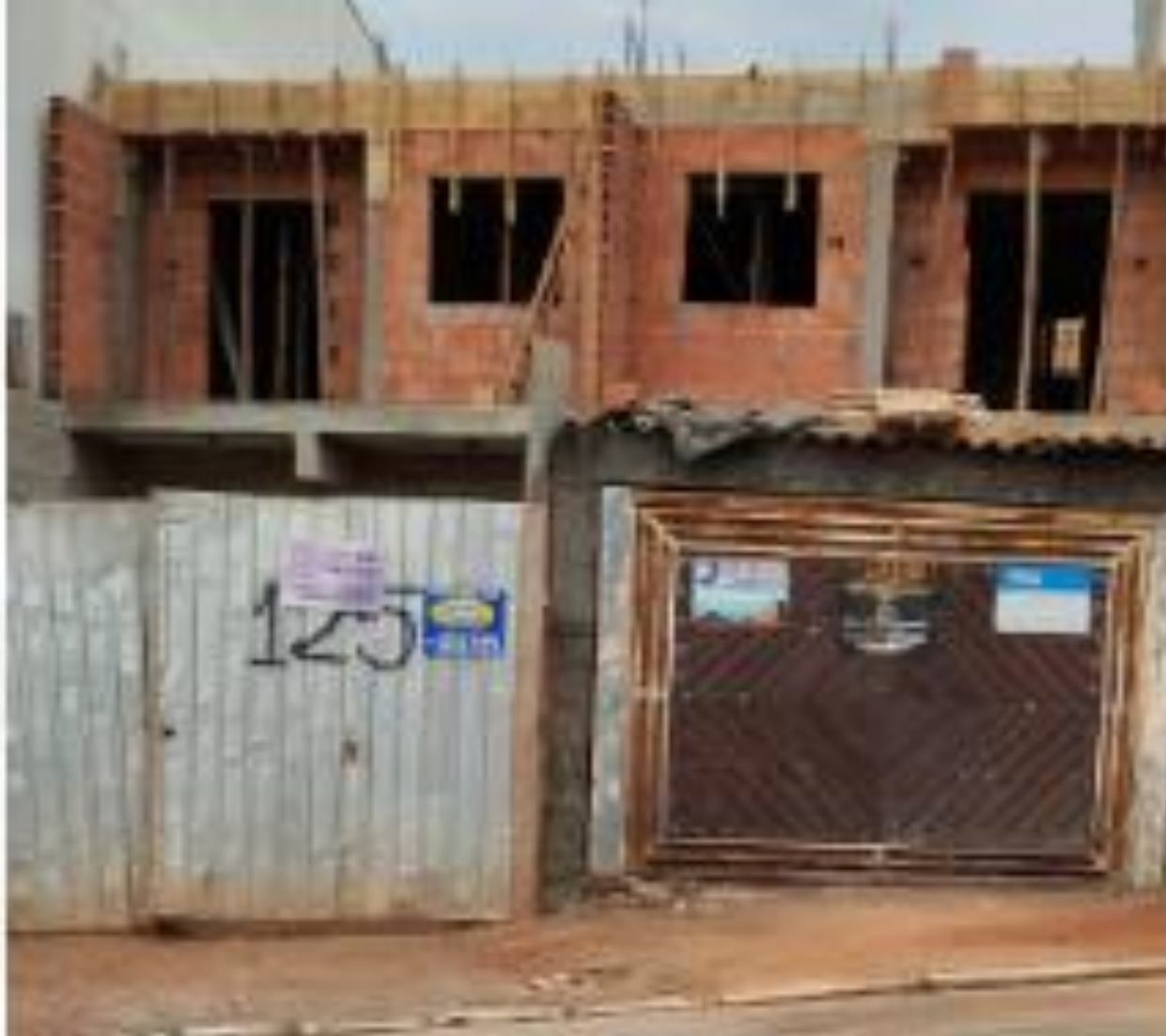
Obra: Residencial Aroeira Condomínio Residencial em Concreto Armado Local: Santo André – SP Ano de Finalização: Em andamento
