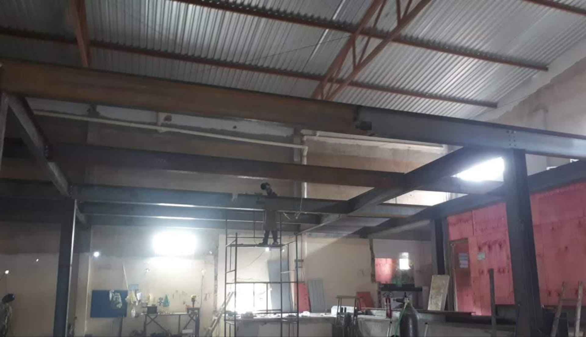
Obra: Estácio de Sá – Campus Gilberto Gil Realização de Estruturas Metálicas, Laje Steel Deck e Cobertura Metálica Local: Salvador – BA Ano de Finalização: 2019
