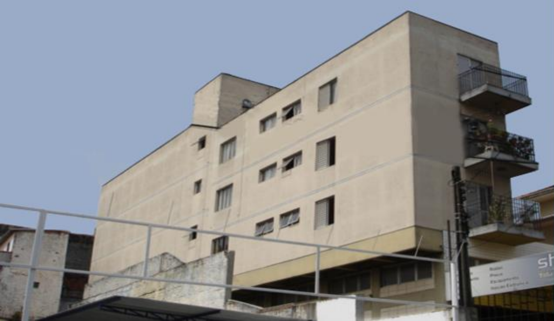
Obra: Prédio Residencial Edifício Residencial em Concreto Armado Local: São Paulo – SP Ano de Finalização: 1998
