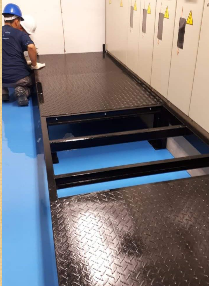
Obra: Hospital Albert Einstein – Unidade Perdizes Realização de Piso Epóxi Monolítico e Plataforma Metálica em Cabine Primária Local: São Paulo – SP Ano de Finalização: 2019
