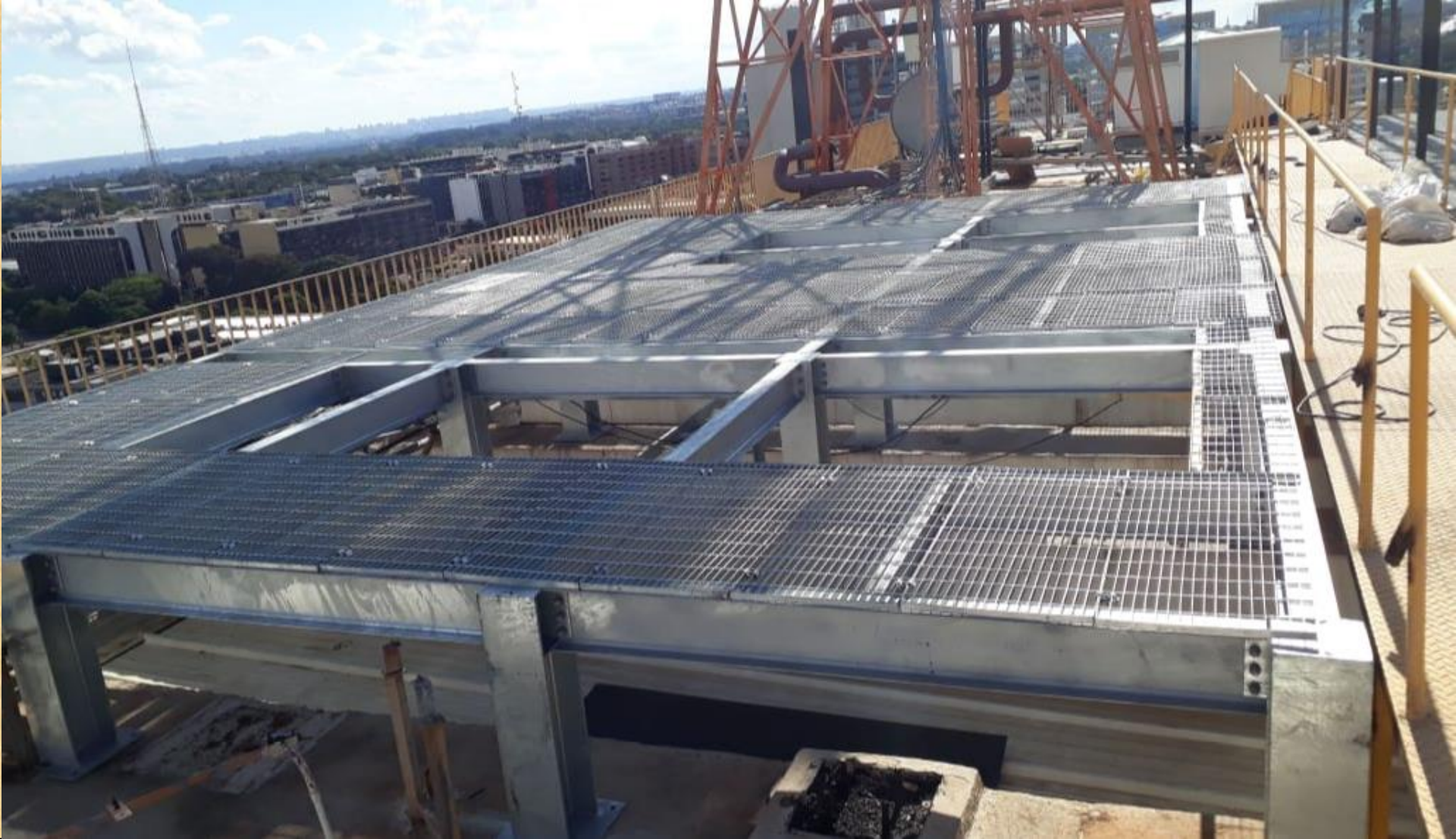
Obra: NET Claro Brasília – Edifício Embratel Realização de Plataforma Metálica e Suporte para Caixas da Água Local: Brasília – DF Ano de Finalização: 2019
