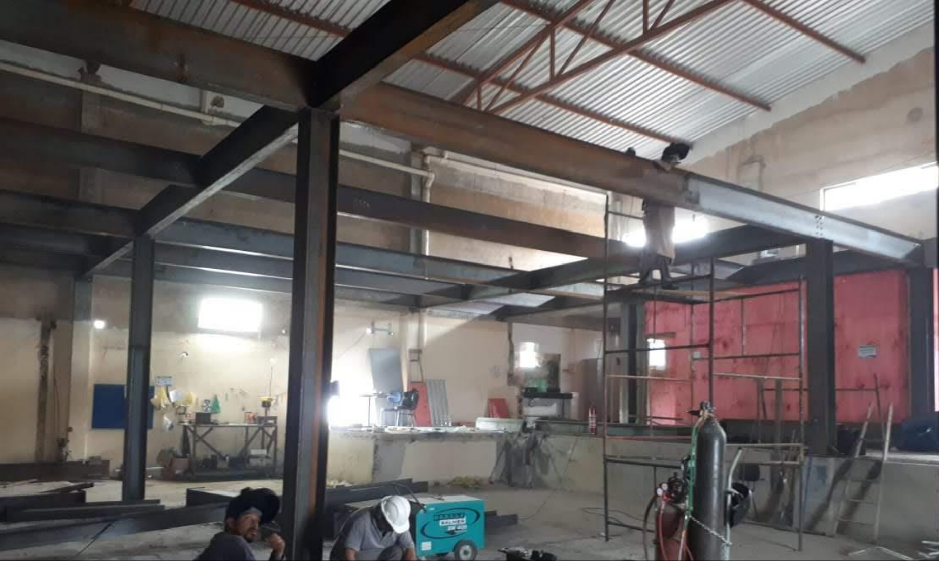
Obra: Estácio de Sá – Campus Gilberto Gil Realização de Estruturas Metálicas, Laje Steel Deck e Cobertura Metálica Local: Salvador – BA Ano de Finalização: 2019
