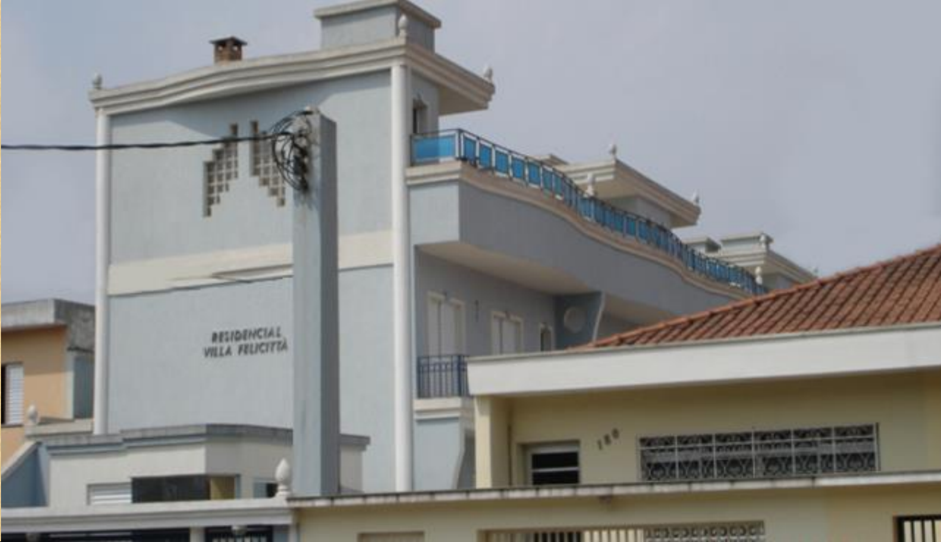
Obra: Residência Vila Felicità Condomínio Residência em Concreto Armado Local: São Paulo – SP Ano de Finalização: 2008
