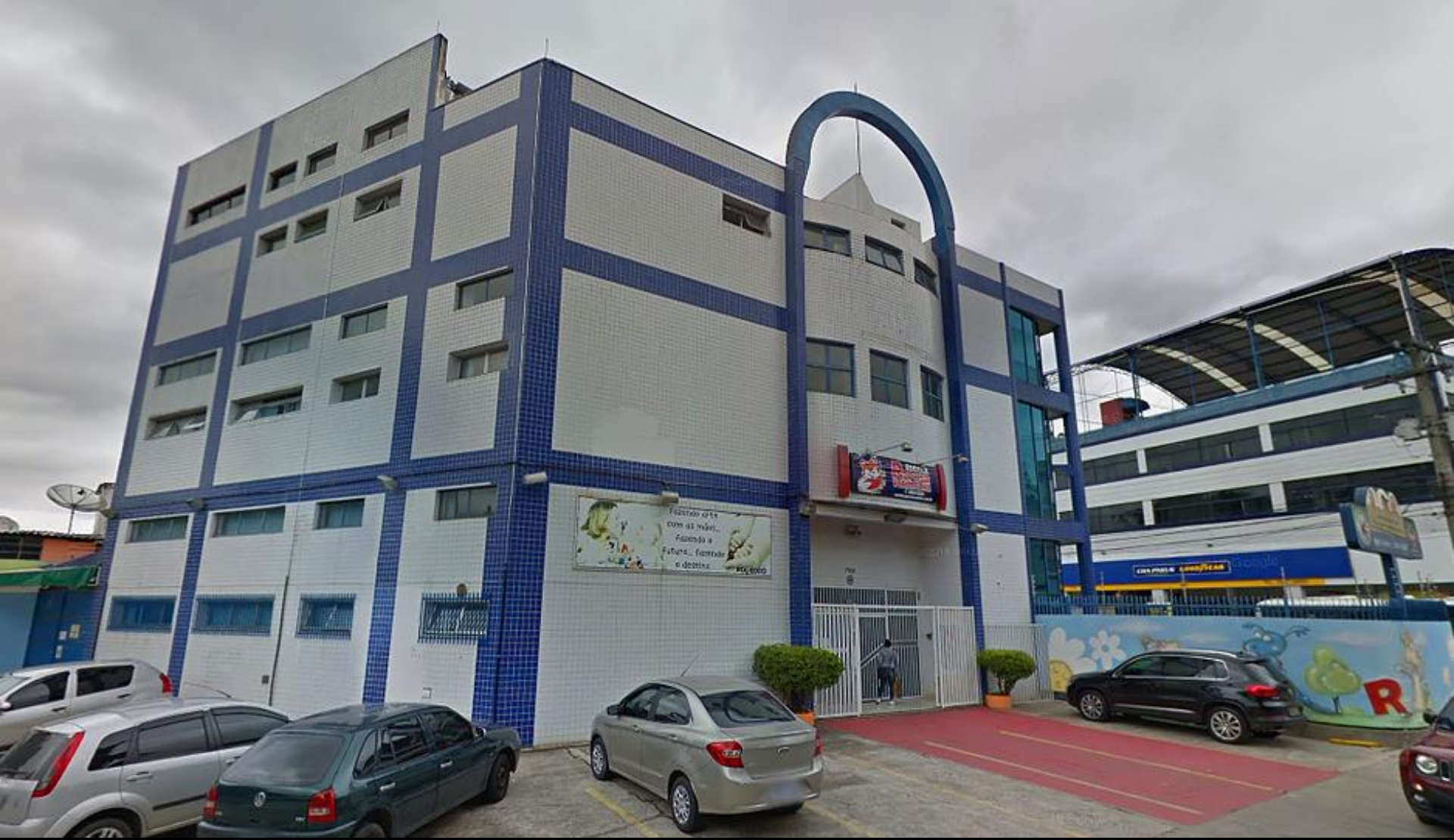
Obra: Escola Raposa Vermelha Edifício Escolar em Concreto Armado Local: São Paulo – SP Ano de Finalização: 2006
