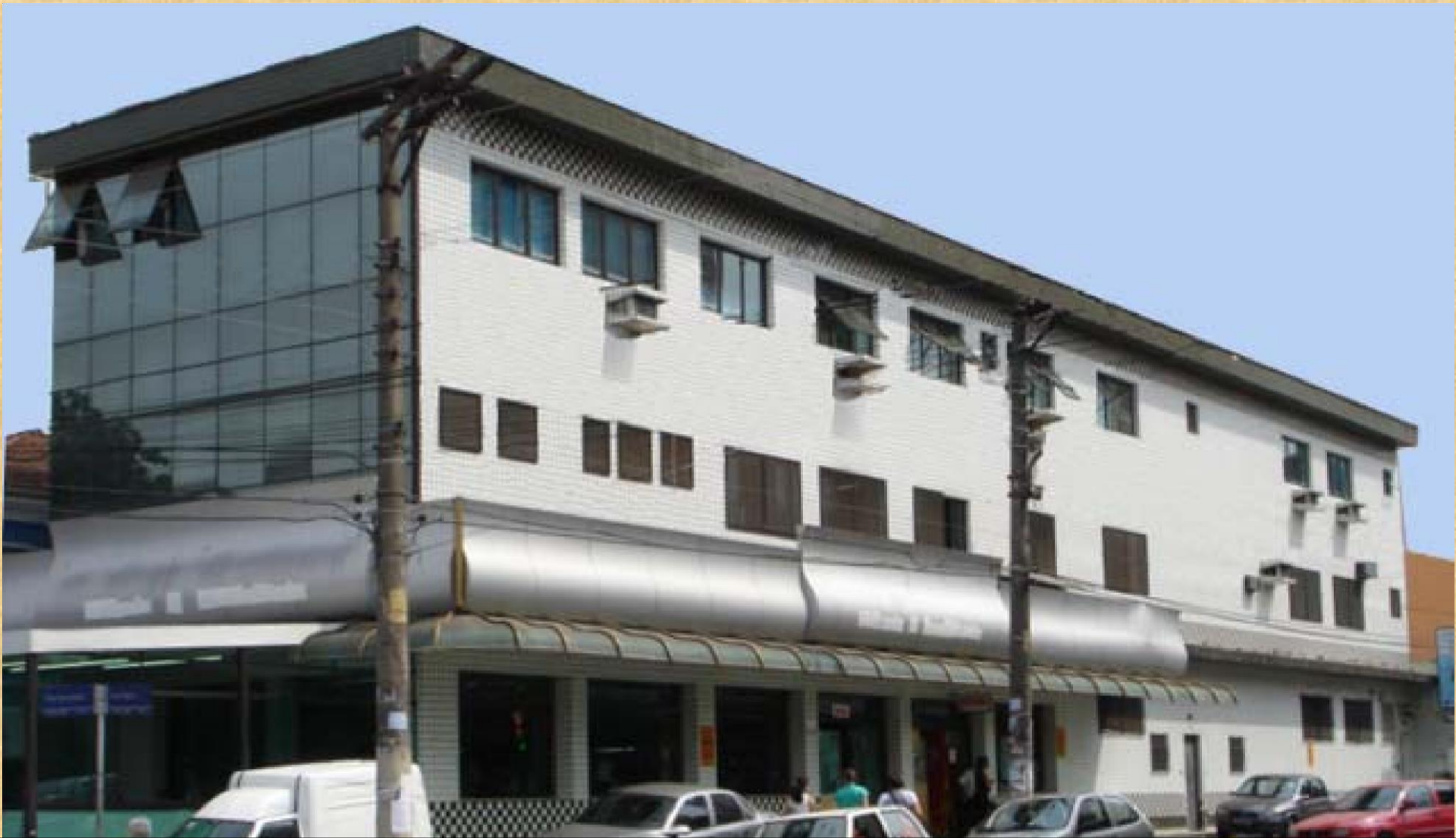
Obra: Big Bread Edifício Comercial em Concreto Armado Local: São Paulo – SP Ano de Finalização: 2002
